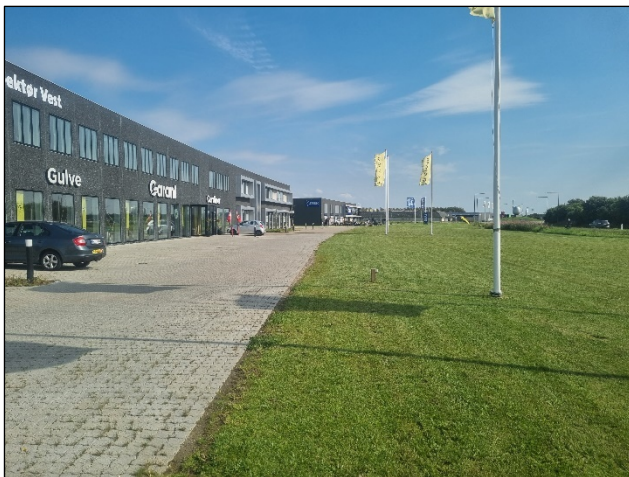
Facadearealet langs Ringvejen, som består af bygning, parkeringsareal og græsbræmmen i lokalplanområdet.
